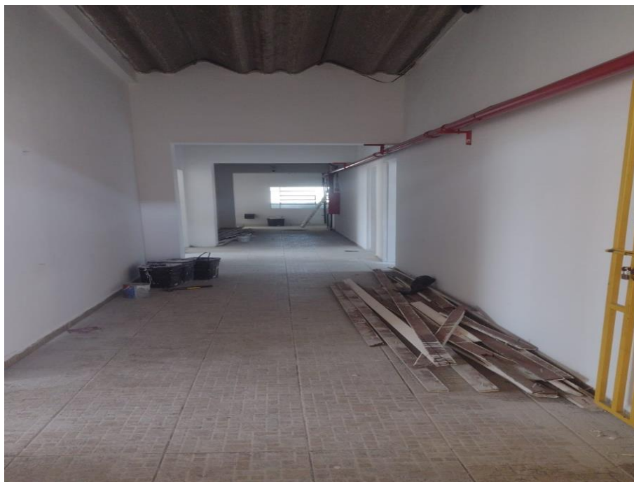
Foto 03: Pintura em Andamento.
