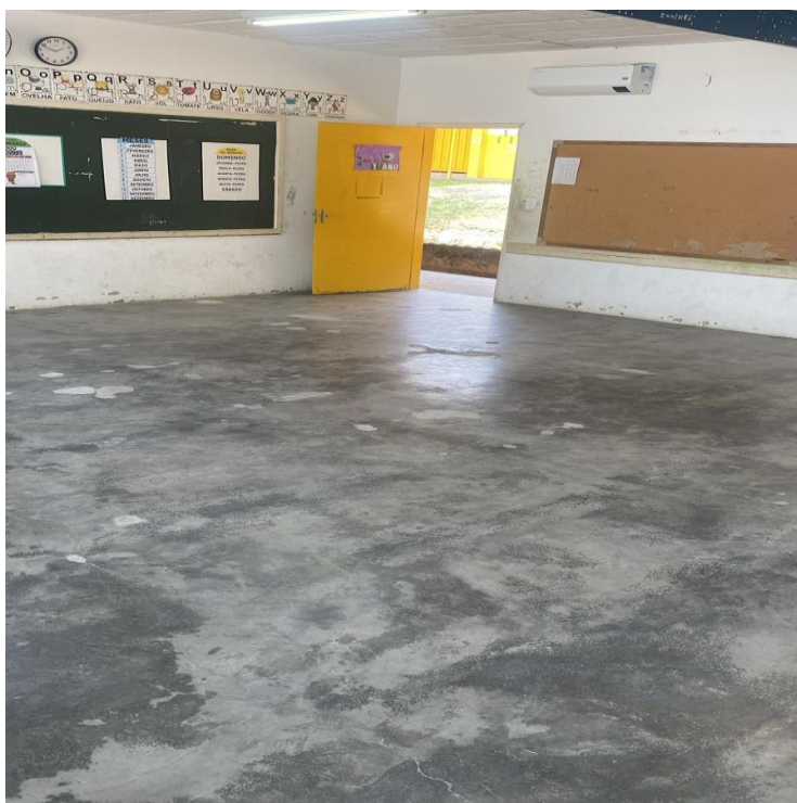
Foto 02: Piso antes da instalação.
