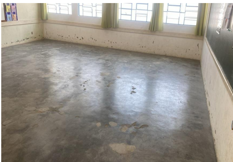
Foto 01: Piso antes da instalação.
