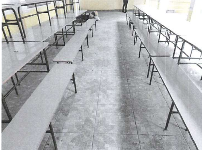
Foto 04: Revestimento cerâmico assentado com argamassa mista.
