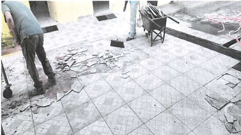
Foto 01: Demolição manual de revestimento cerâmico.
