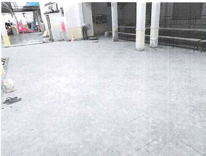
Foto 05: Revestimento cerâmico assentado com argamassa mista.
