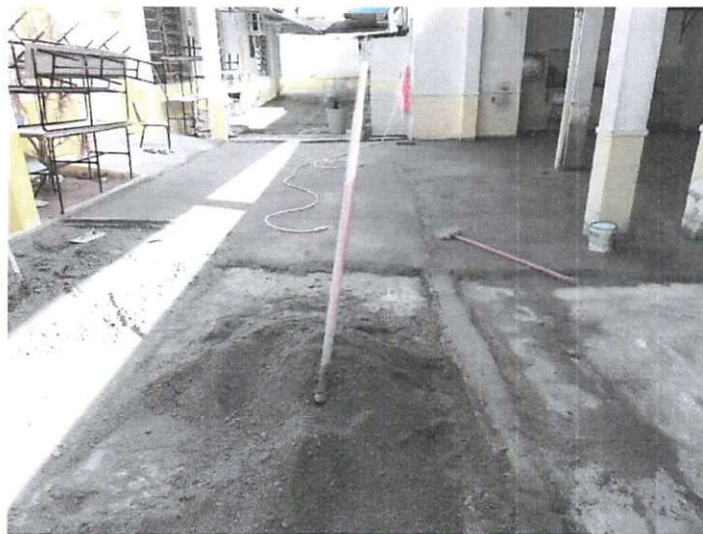
Foto 02: Argamassa de regularização e/ou proteção.
