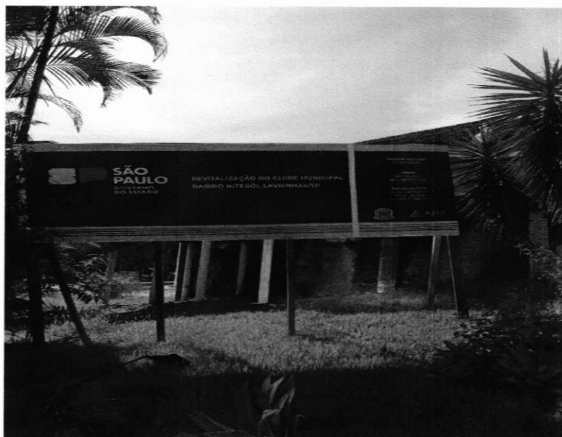
Foto 01 – Placa de Obra.
