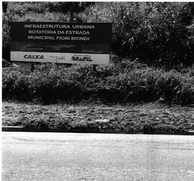
Foto 01 – Placa de Obra.
