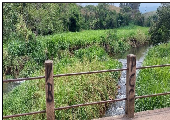
FIGURA 72 PONTE SOBRE O RIO DO BRAÇO FONTE :ACERVO DO AUTOR 2021
