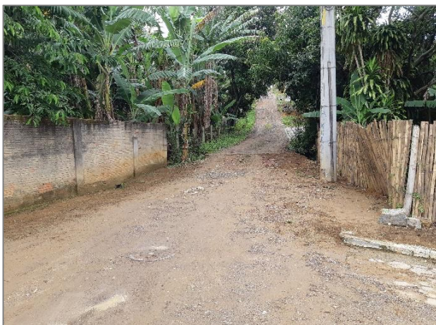
QUADRO 13 – FALTA DE PAVIMENTAÇÃO NO BAIRRO NITERÓI FONTE: ACERVO DO AUTOR, 2021
