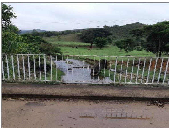
FIGURA 69 PONTE DE ACESSO BAIRRO RETIRO DOS BARBOSAS FONTE: ACERVO DO AUTOR 2021
