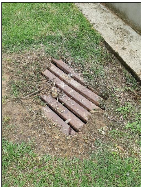
FIGURA 75 - BOCA DE LOBO PRÓXIMO A ETE CAPELA DO JACU FONTE: ACERVO DO AUTOR, 2021
