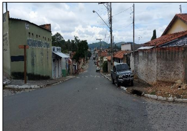
FIGURA 80 - BOCA DE LOBO NA ESQUINA FONTE: ACERVO DO AUTOR 2021
