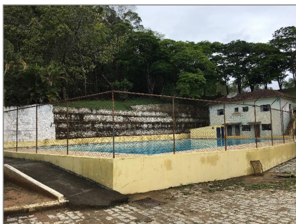
FIGURA 32 – PISCINA PÚBLICA PRÓXIMO A RODOVIÁRIA FONTE: ACERVO DO AUTOR, 2021
