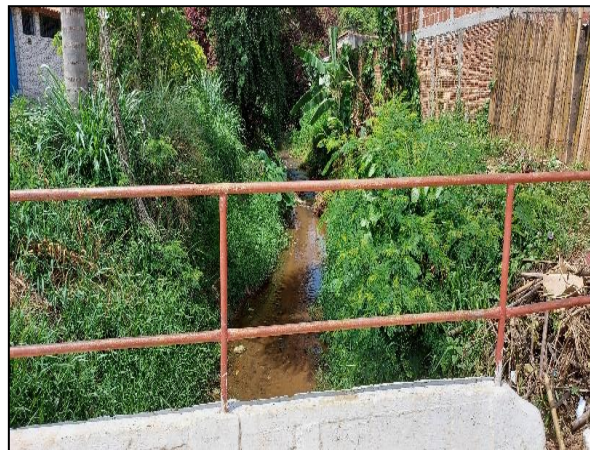
FIGURA 70 PONTE DE ACESSO BAIRRO PINHEIRINHO FONTE: ACERVO AUTOR 2021
