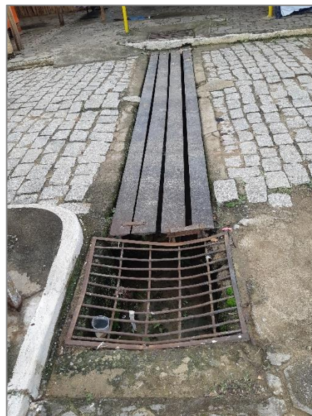
FIGURA 160 – BOCA DE LOBO PRÓXIMA A PRAÇA CAPELA DO JACU FONTE: ACERVO DO AUTOR, 2021
