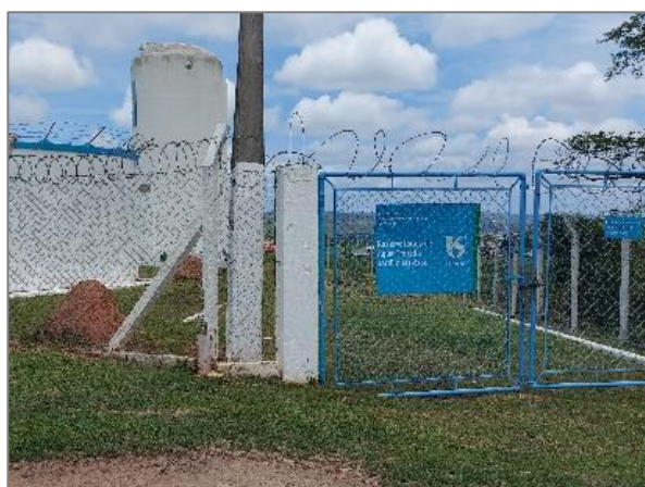
FIGURA 141 - RESERVATÓRIO JARDIM MAVISOU FONTE: ACERVO DO AUTOR, 2021
