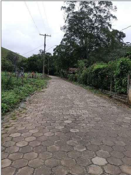
FIGURA 167 - DRENAGEM SUPERFICIAL NO BAIRRO RETIRO DOS BARBOSAS – VISTA 1 FONTE: ACERVO DO AUTOR, 2021
