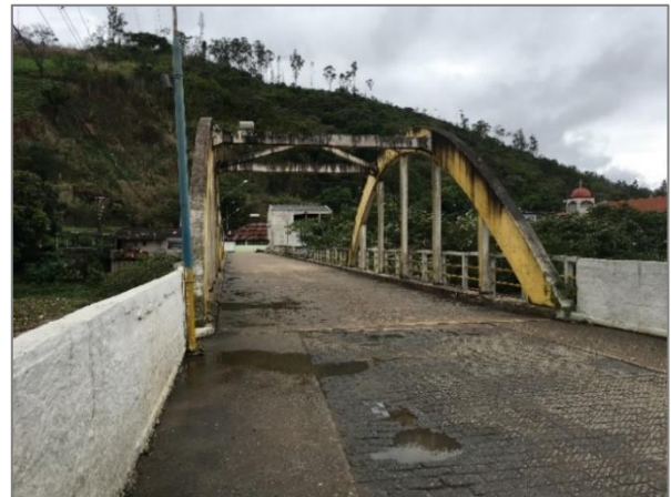
FIGURA 152 PONTE SOBRE RIO PARAÍBA FONTE: ACERVO DO AUTOR 2021
