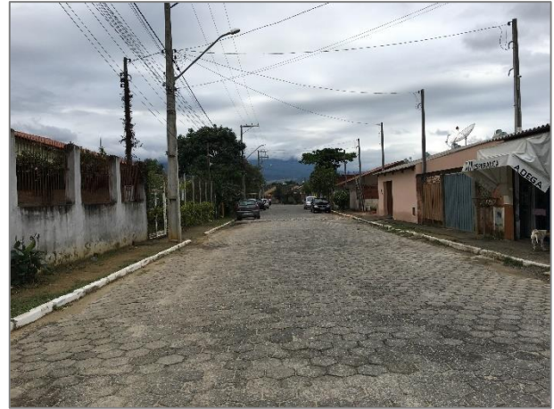
QUADRO 74 – CALÇAMENTO BAIRRO RECANTO TRANQUILO FONTE: ACERVO DO AUTOR, 2021
