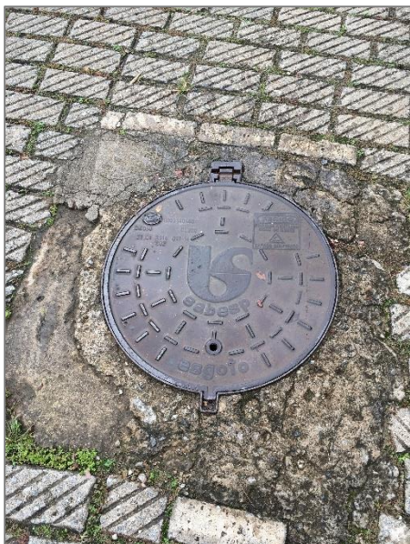
FIGURA 143 - POÇO DE VISITA – VISTA 1 FONTE: ACERVO DO AUTOR, 2021
