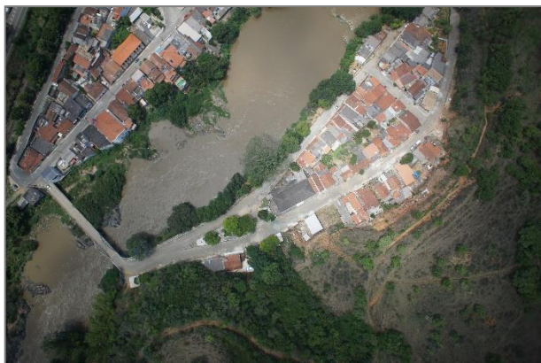
QUADRO 89 – PONTE SOBRE O PARAÍBA, BAIRRO CENTRO E NITEROI FONTE: ACERVO DO AUTOR, 2021
