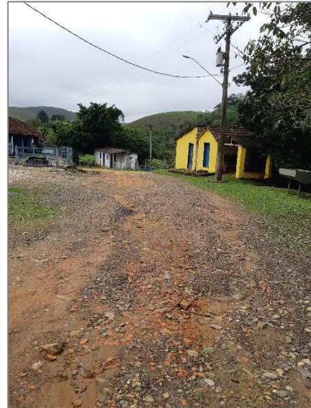
FIGURA 168 - DRENAGEM SUPERFICIAL NO BAIRRO RETIRO DOS BARBOSAS – VISTA 2 FONTE: ACERVO DO AUTOR, 2021
