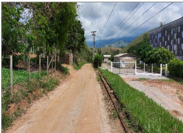
FIGURA 165 – ÁREAS NÃO PAVIMENTADAS EM ÁREA RURAL FONTE: ACERVO DO AUTOR, 2021
