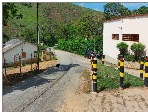
FIGURA 111 – RUA DE ACESSO A EMPRESA COINBAL COMÉRCIO E INDÚSTRIA DE MINÉRIOS PAVIMENTADA FONTE: ACERVO DO AUTOR, 2021
