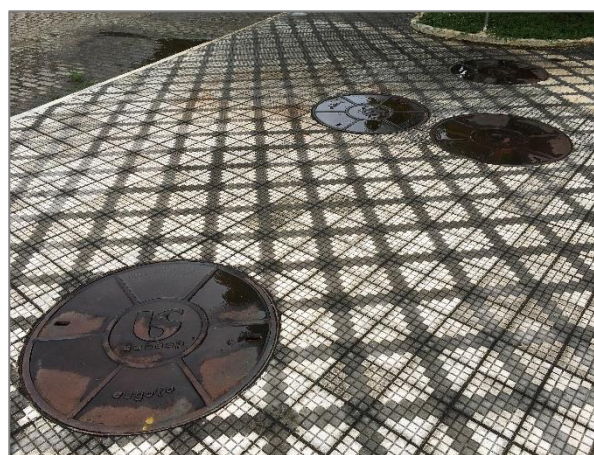
FIGURA 144 - POÇO DE VISITA – VISTA 2 FONTE: ACERVO DO AUTOR, 2021
