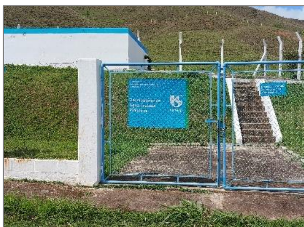
FIGURA 140 – RESERVATÓRIO PINHEIROS FONTE: ACERVO DO AUTOR, 2021
