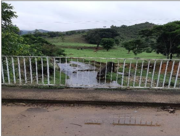
FIGURA 153 PONTE DE ACESSO BAIRRO RETIRO DOS BARBOSAS FONTE: ACERVO DO AUTOR 2021
