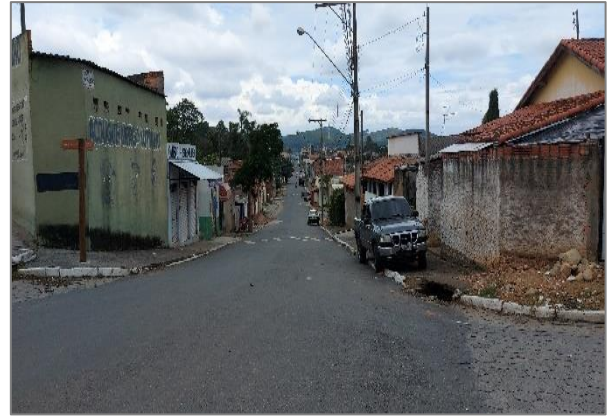
FIGURA 164 - BOCA DE LOBO NA ESQUINA FONTE: ACERVO DO AUTOR 2021
