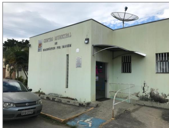
FIGURA 457 – CARTAZ INSTALADO NO CENTRO DIAGNÓSTICO - VISTA 02
