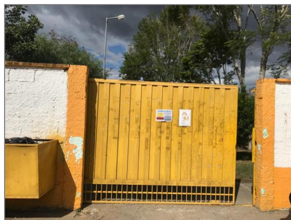
FIGURA 467 – CARTAZ INSTALADO NA ESCOLA MARIO COVAS - VISTA 02 FONTE: ACERVO DO AUTOR, 2022
