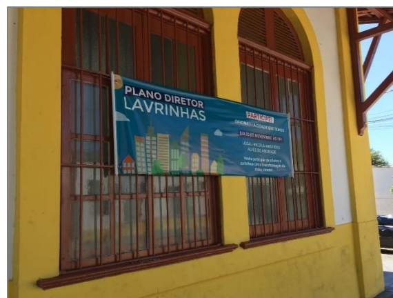
FIGURA 216 – FAIXA INSTALADA NA FACHADA DA PREFEITURA - VISTA 02 FONTE: ACERVO DO AUTOR, 2021
