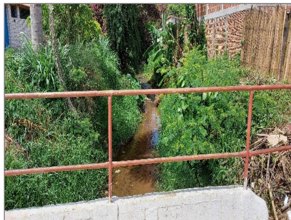
FIGURA 154 PONTE DE ACESSO BAIRRO PINHEIRINHO FONTE: ACERVO AUTOR 2021
