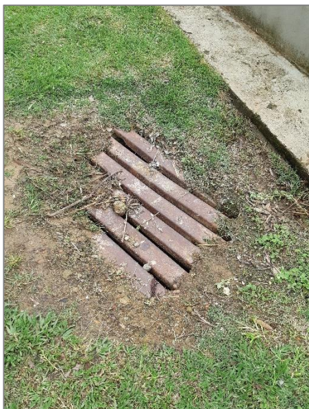
FIGURA 159 - BOCA DE LOBO PRÓXIMO A ETE CAPELA DO JACU FONTE: ACERVO DO AUTOR, 2021
