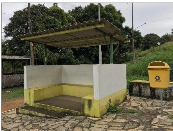
FIGURA 170 – COLETOR NO CENTRO FONTE: ACERVO DO AUTOR, 2021
