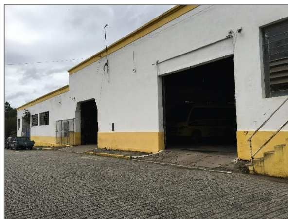
FIGURA 362 – GARAGEM MUNICIPAL FONTE: ACERVO DO AUTOR, 2021
