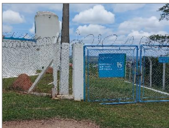
FIGURA 141 - RESERVATÓRIO JARDIM MAVISOU FONTE: ACERVO DO AUTOR, 2021
