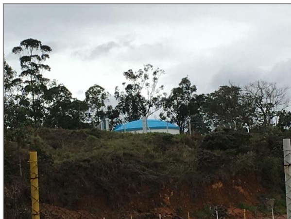
FIGURA 138 – RESERVATÓRIO JARDIM MAVISOU FONTE: ACERVO DO AUTOR, 2021
