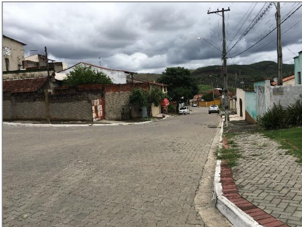
QUADRO 75 – CALÇAMENTO VILAGE CAMPESTRE FONTE: ACERVO DO AUTOR, 2021
