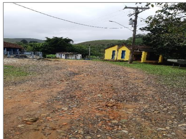
QUADRO 69 – FALTA DE PAVIMENTAÇÃO NO BAIRRO RETIRO DOS BARBOSAS FONTE: ACERVO DO AUTOR, 2021
