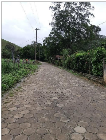
FIGURA 167 - DRENAGEM SUPERFICIAL NO BAIRRO RETIRO DOS BARBOSAS – VISTA 1 FONTE: ACERVO DO AUTOR, 2021
