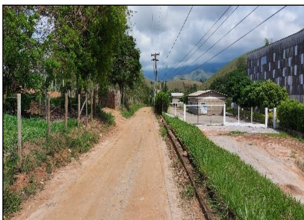
FIGURA 350 – ÁREAS NÃO PAVIMENTADAS EM ÁREA RURAL FONTE: ACERVO DO AUTOR, 2021
