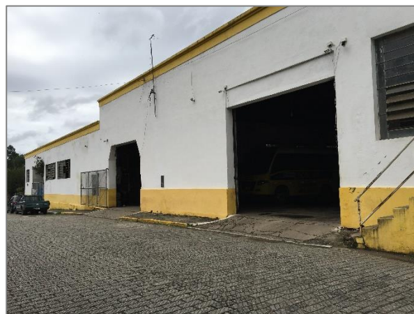
FIGURA 78 – GARAGEM MUNICIPAL FONTE: ACERVO DO AUTOR, 2021
