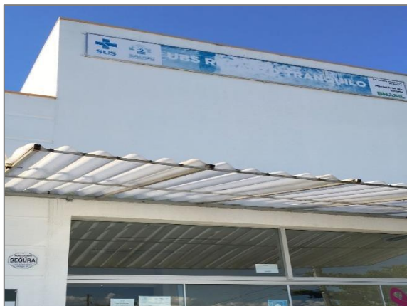
FIGURA 237 – CARTAZ INSTALADO NA UBS RECANTO TRANQUILO - VISTA 01 FONTE: ACERVO DO AUTOR, 2021
