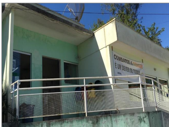
FIGURA 221 – CARTAZ INSTALADO NO PSF PINHEIROS - VISTA 01 FONTE: ACERVO DO AUTOR, 2021
