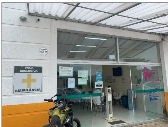
FIGURA 416 – CARTAZ INSTALADO NA UBS RECANTO TRANQUILO - VISTA 01 FONTE: ACERVO DO AUTOR, 2022
