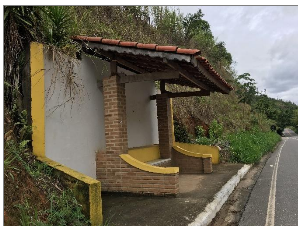
FIGURA 184 – PONTO NA RODOVIA JÚLIO FORTES FONTE: ACERVO DO AUTOR, 2021
