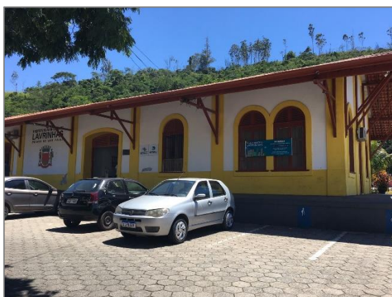
FIGURA 215 – FAIXA INSTALADA NA FACHADA DA PREFEITURA - VISTA 01 FONTE: ACERVO DO AUTOR, 2021
