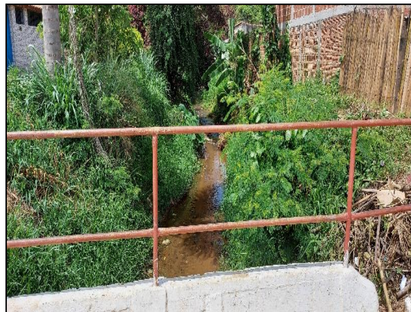
FIGURA 339 PONTE DE ACESSO BAIRRO PINHEIRINHO FONTE: ACERVO AUTOR 2021
