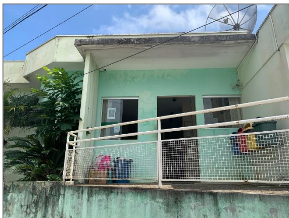
FIGURA 404 – CARTAZ INSTALADO NO PSF PINHEIROS - VISTA 01 FONTE: ACERVO DO AUTOR, 2022
